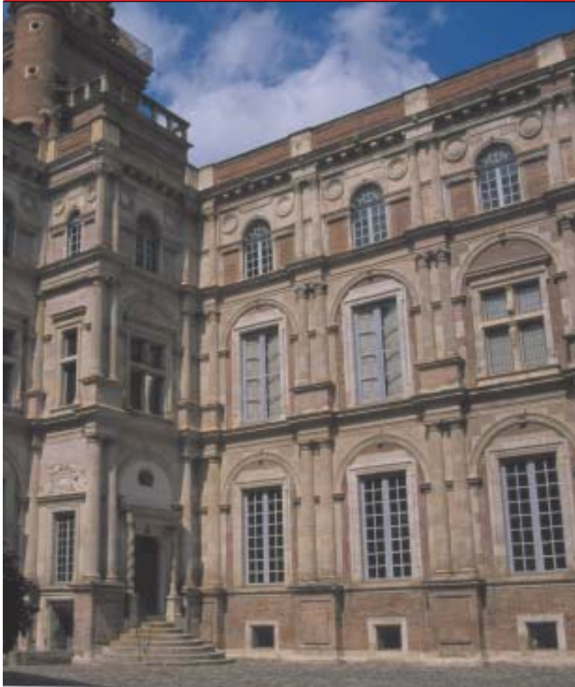
写真-9 アセザ館
